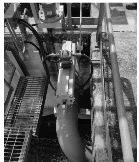
วาล์วควบคุมทิศทางการไหลของน้ำหล่อเย็นไปยังบ่อพักน้ำหล่อเย็น 2 และบ่อฉุกเฉิน
